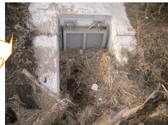
予備ゲート整備による津波逆流被害防止の状況 (浜名谷地排水樋管)
