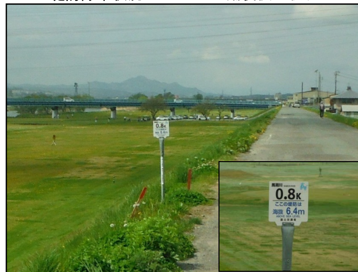
堤防の海拔情報入り距離標表示板の設置 (H25. 5月設置)
