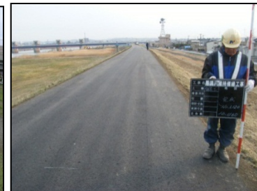
舗装後の状況
