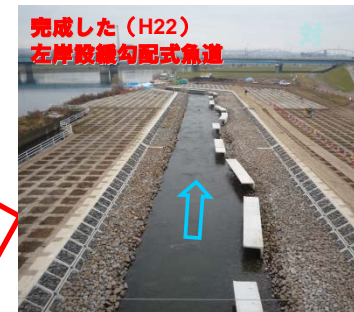
緩勾配式魚道に改築することにより、遡上環境を向上
