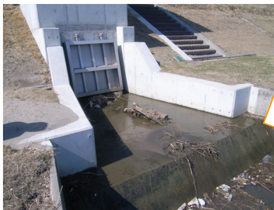
予備ゲートの整備
