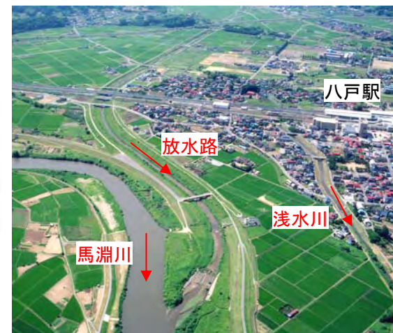
整備状況 (区間①)
