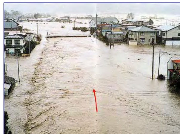
平成11年10月洪水 浅水川 八戸市三條目地内
