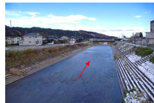
整備状況 (区間②)
