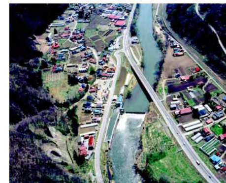
【舌崎発電所取水口】
