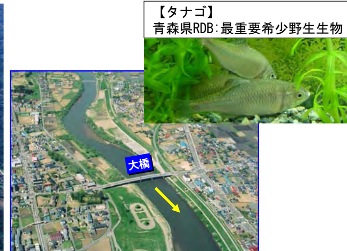
整備された緑豊かな高水敷
