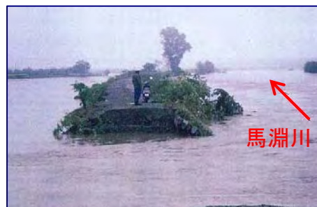
平成2年9月洪水（馬淵川南部町） 虎渡地区の破堤状況
