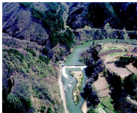
【小中島発電所取水口】
