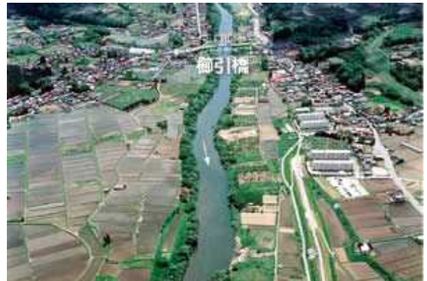
河道の様子(櫛引橋～尻内橋の間)
