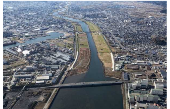
馬淵川放水路
