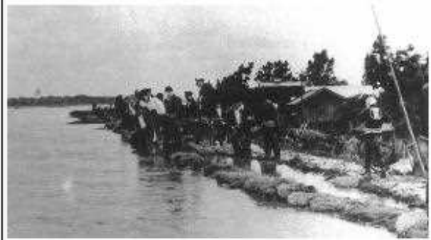
あふれる岩木川（中泊町長泥地区）
