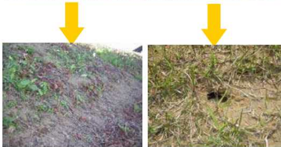
堤防の裸地化
