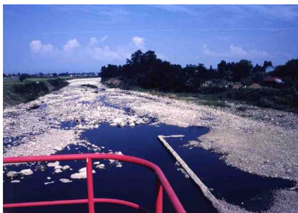
水量の減少した岩木川（平成 8 年 統合頭首工付近）
