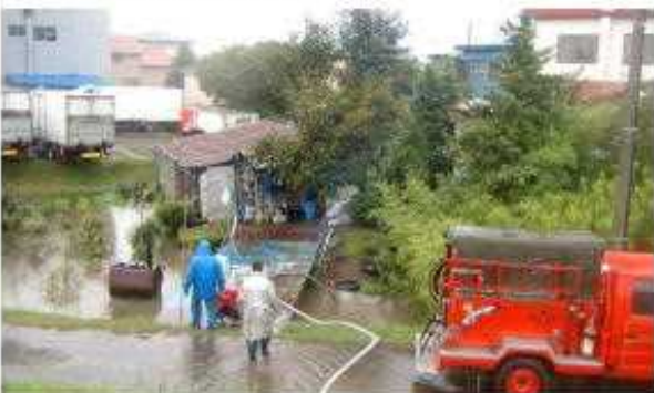
内水排除状況（弘前市大久保地区）
