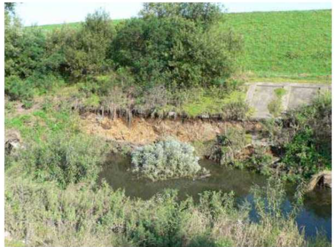
洪水による護岸の損傷の状況
