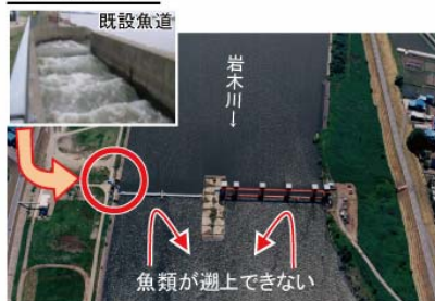
芦野堰（魚類の遡上環境の改善が必要）
