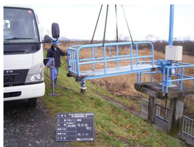
老朽化した管理橋の更新
