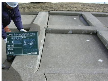
護岸の損傷
