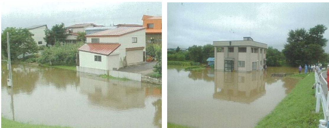
平成14年8月洪水による内水被害の状況（弘前市 鳴瀬地区）
