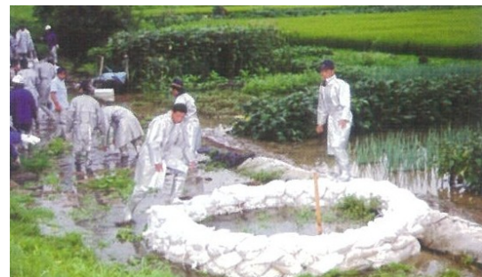
漏水による水防活動の状況
