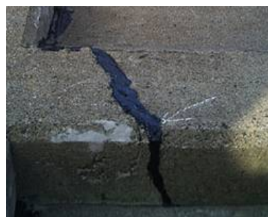
護岸の補修状況
