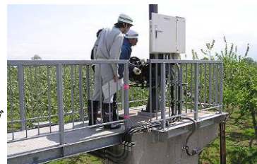
樋門・樋管 の点検状況
