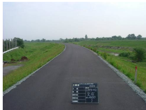
舗装後の状況
