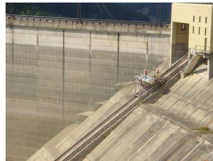
繫船設備点検の様子
