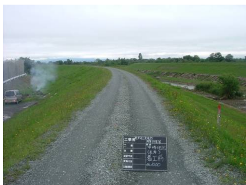
舗装前の状況
