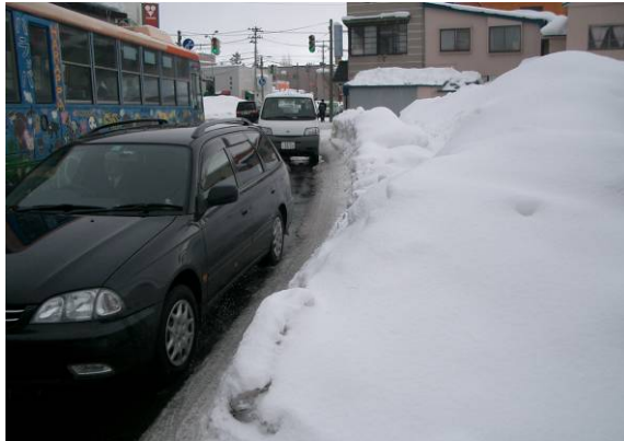
降り積もった雪堤で道路幅員が減少 (交通機能障害が顕在化)
