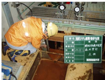
ダム堤体の漏水量の調査
