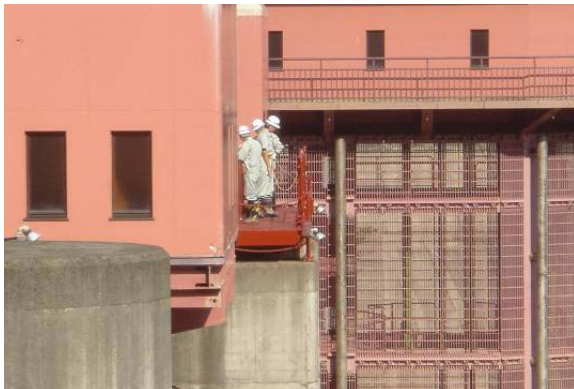
浅瀬石川ダム点検の様子
