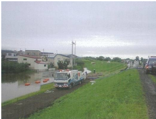
弘前市鳴瀬地区での内水排除状況
