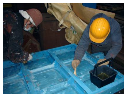
ゲートの補修
