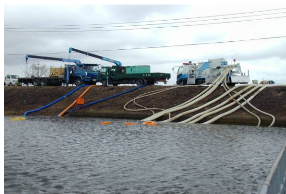
五所川原市相原地内での内水排除状況
