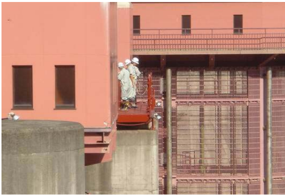
浅瀬石川ダム点検の様子
