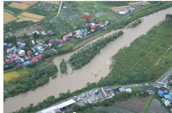
河道内樹木が繁茂し洪水の流下を阻害している状況
