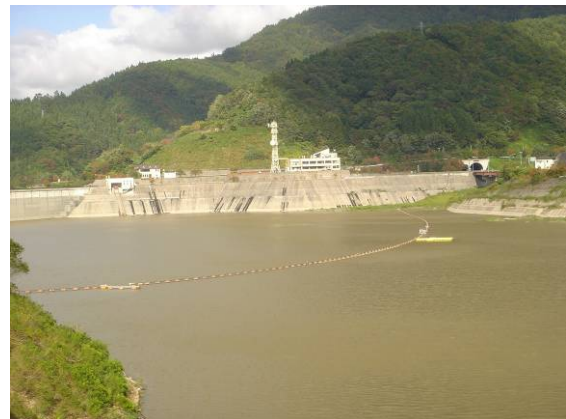
浅瀬石川ダム 流木止施設
