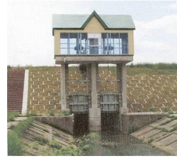
平川第五排水樋管 (出典：青森河川国道事務所)
