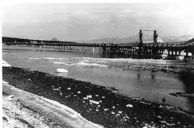
竣工直後の木橋
