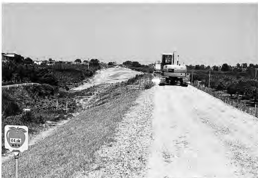
施工中の青女子築堤（平成10年）
