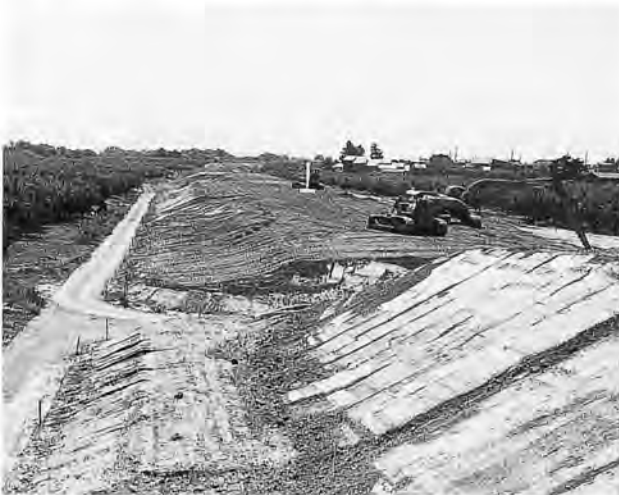
施工中の種市築堤 (41km) (平成10年)
