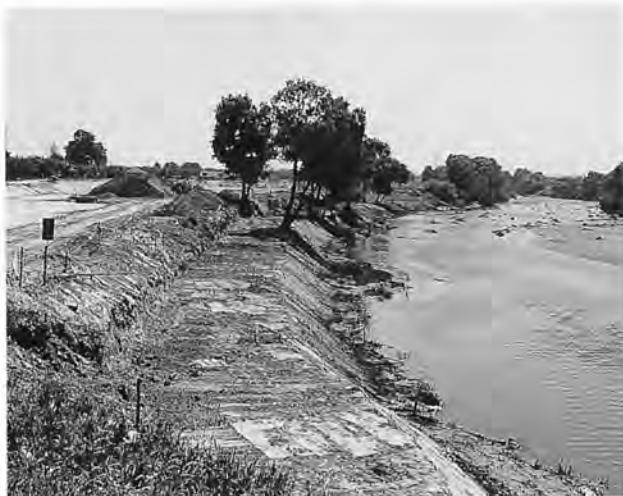
施工中の右岸低水路掘削 玉川樋管上流（平成10年）
