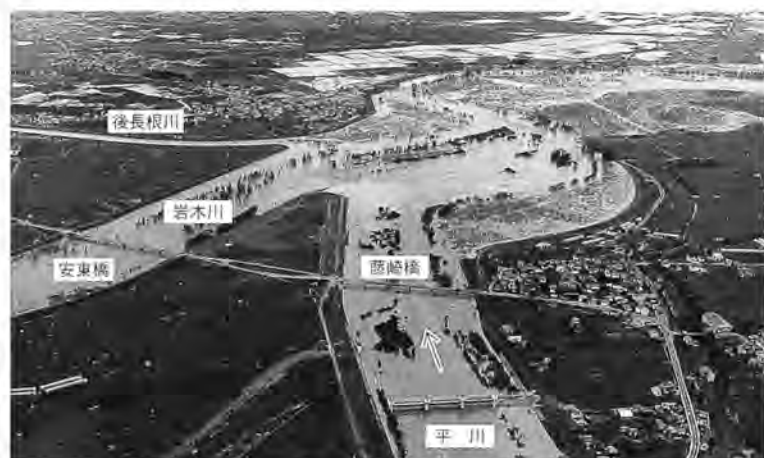
岩木川・平川合流点 平成9年5月8日洪水
