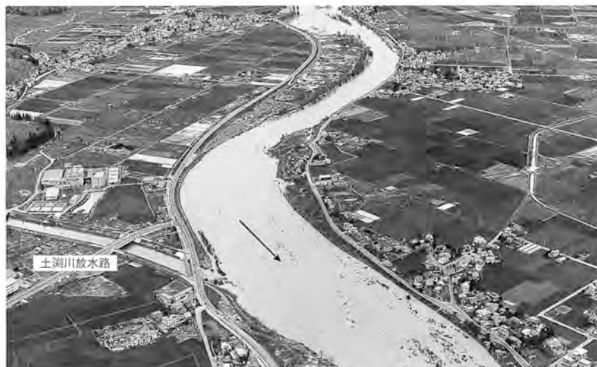
土淵川放水路合流点 平成9年5月洪水
