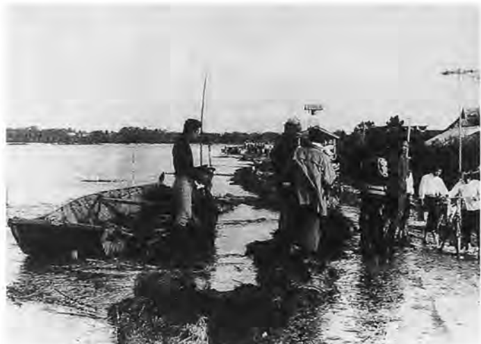
昭和33年9月洪水で堤防天端に3段積の土のうで越水破堤をまぬがれた右岸武田築堤8km附近
