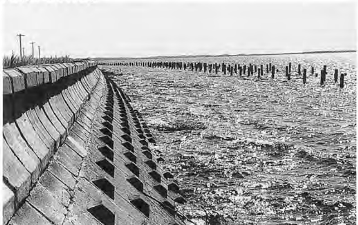
昭和30年に竣功した右岸圍繞堤
