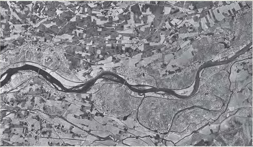
33.5kmから38.8kmの範囲で、当時の国が直接工事する区間の上流端を河口から38.3 kmとして始めたため、700～0間に堤防法線を定めていました。右岸堤防-5から55までは旧堤防を利用し、55から下流は新しく堤防を造っています。左岸は30付近から工事を進めたようです。ここは現在、川村水門が造られている所です。
