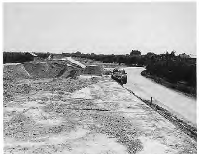
施工中の右岸板柳地区小幡築堤（平成10年）
