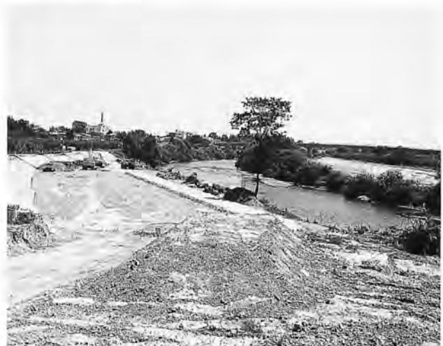
施工中の幡竜橋下流右岸低水路掘削 (平成10年)
