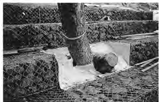
写真－2 樹木存置のための切欠
