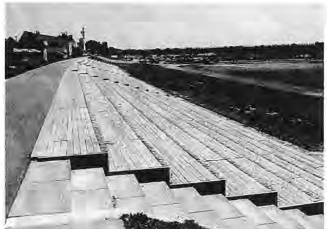
北斗グランド階段護岸
