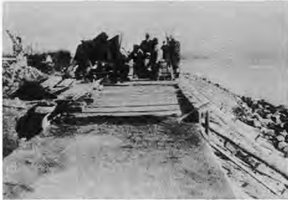
北突堤工事（昭和6年10月24日）
