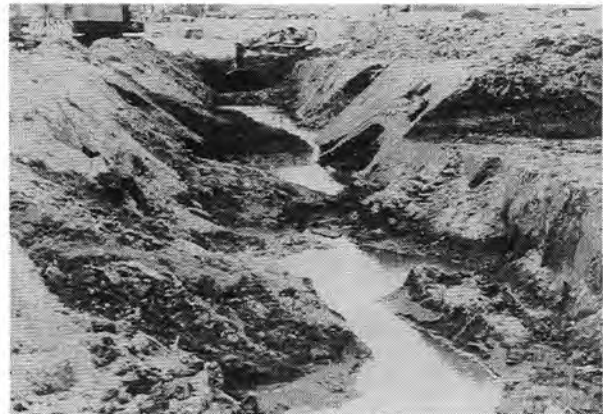
芦野堰関連工事
