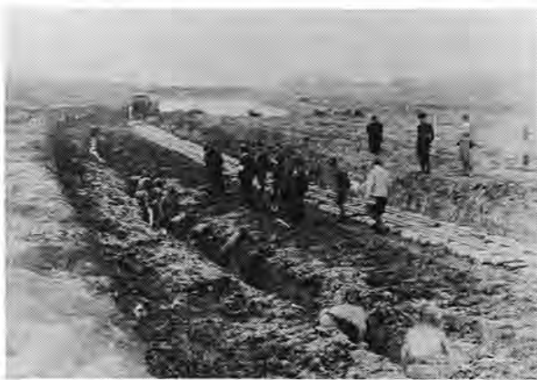
新十川掘削工事（昭和10年）
