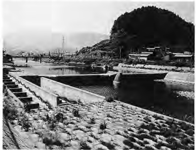
水喧嘩のあった現在の平川第一頭首工
