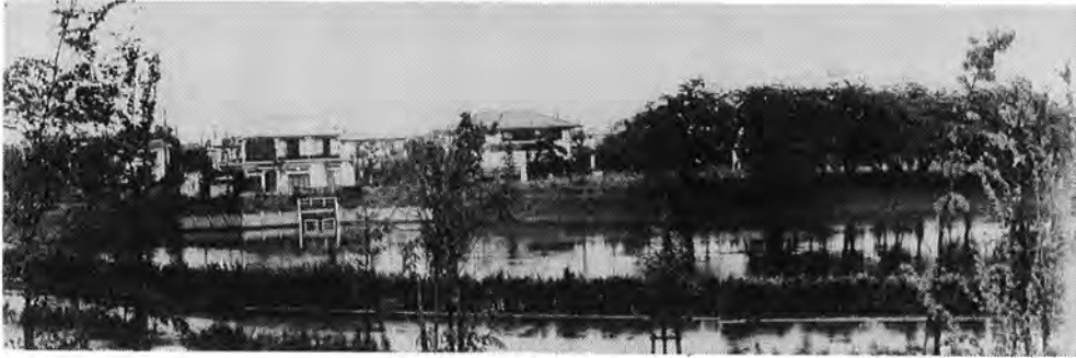
長四郎雨水貯留施設湛水状況
