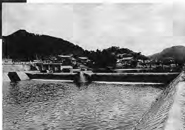
下流からみた平川第1頭首工
