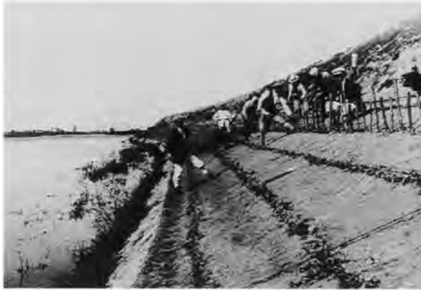
栄第一護岸工事（大正14年）
