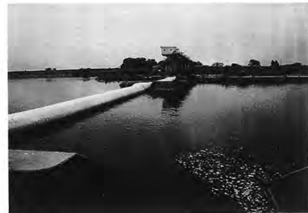
完成した芦野頭着工
