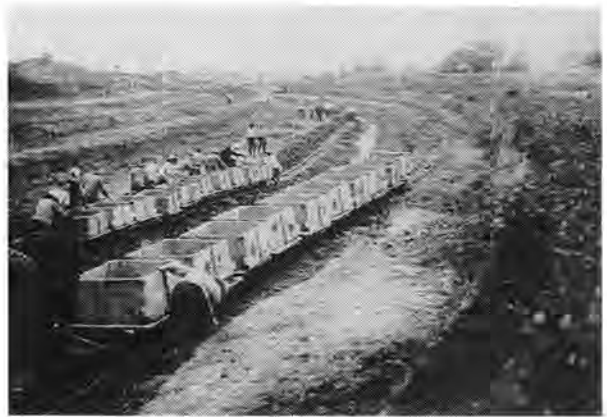
新十川掘削工事（昭和5年8月）
