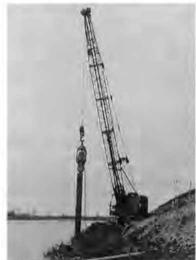
菅蒲川護岸工事(昭和47年度)
