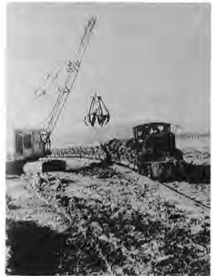
クラムシェル積込作業(昭和34年)
