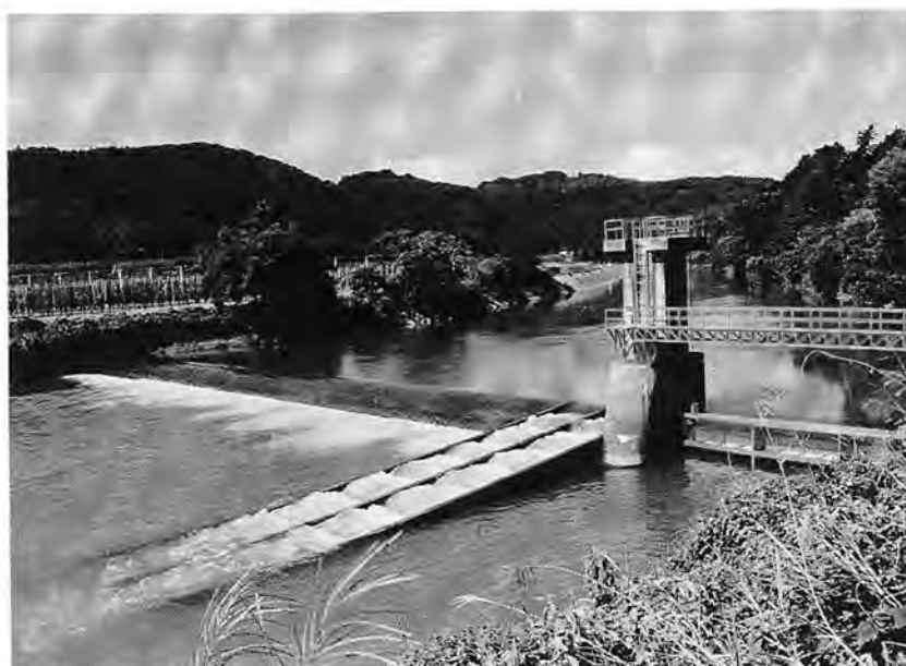
杭止堰頭首工
