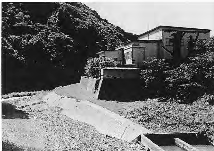
クマゲラが描かれている岩木第一発電所
