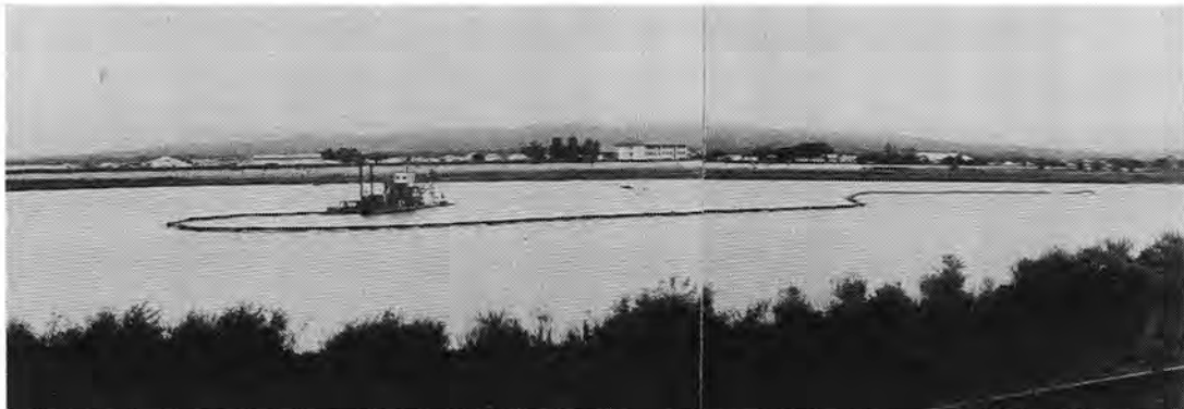
芦野地区浚渫工事(平成元年度)
