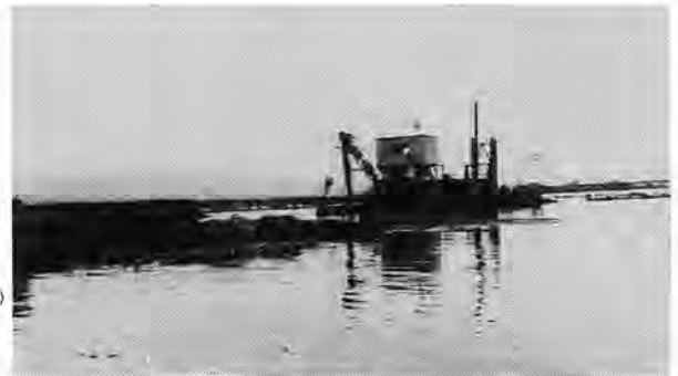
武田地区浚渫工事（昭和58年度）
