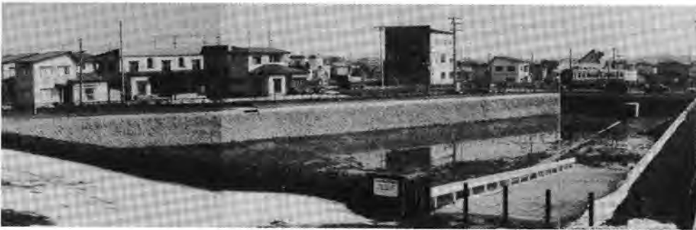
小比内雨水貯留施設（昭和60年完成）
