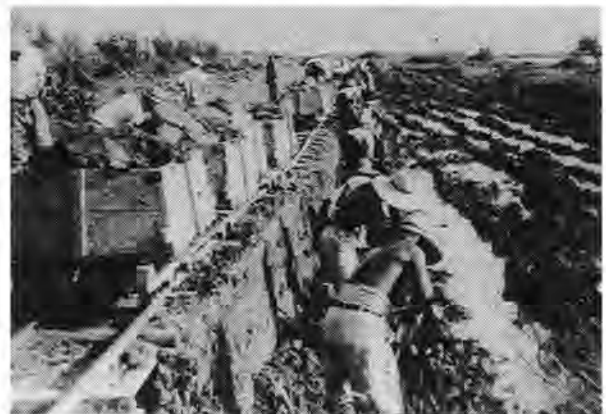
下流武田築堤工事 人力積み込み作業(昭和38年)
