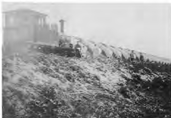
運搬機（蒸気機関）と土運車
