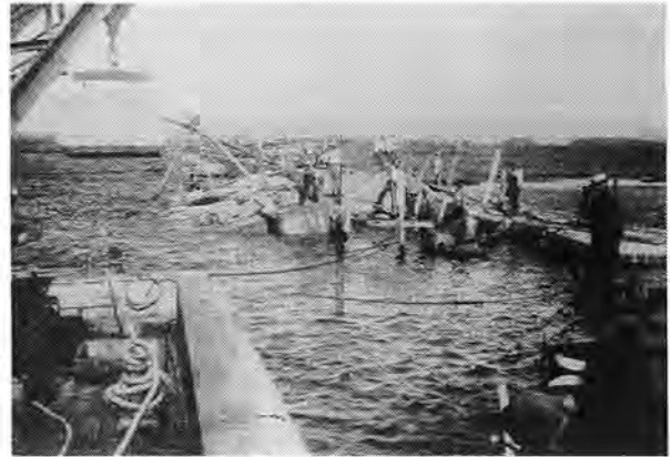
南突堤工事（昭和8年8月4日）
