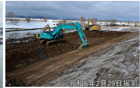
河道掘削状況
