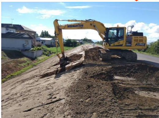
▲堤防強化（盛土）施工状況
