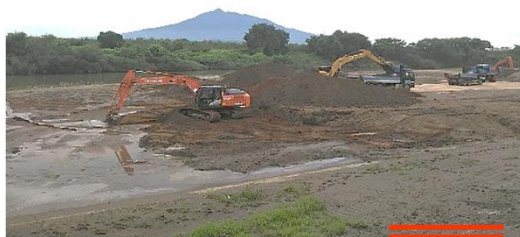
▲河道掘削の状況
