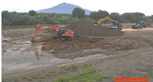
▲河道掘削の状況
