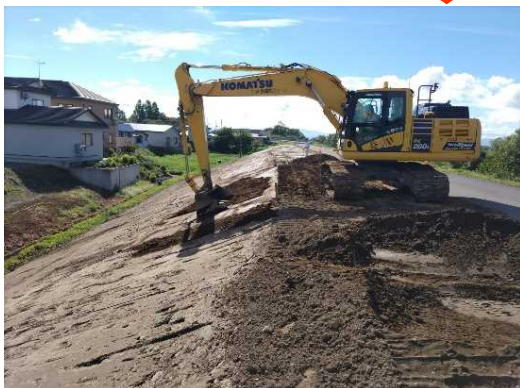
▲堤防強化（盛土）施工状況
