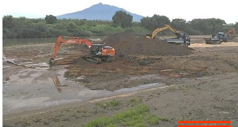
▲河道掘削の状況
