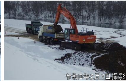
河道掘削状況
