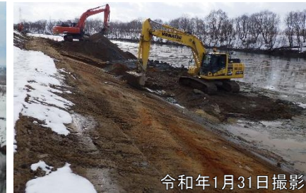
河道掘削状況
