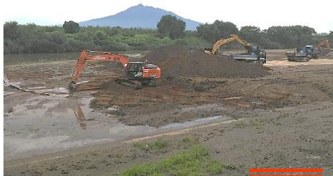
▲河道掘削の状況
