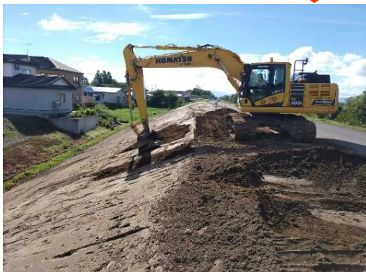
▲堤防強化（盛土）施工状況
