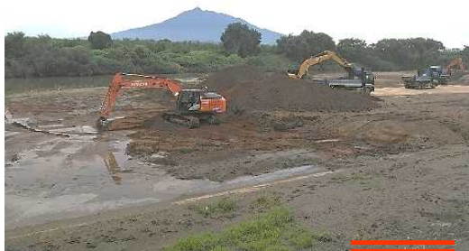
▲河道掘削の状況
