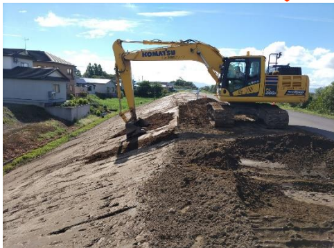
▲堤防強化（盛土）施工状況
