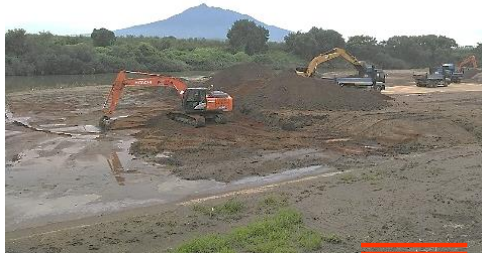
▲河道掘削の状況
