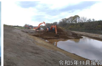
河道掘削状況
