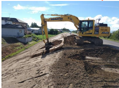
▲堤防強化（盛土）施工状況
