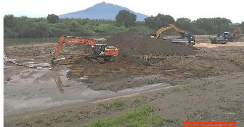
▲河道掘削の状況
