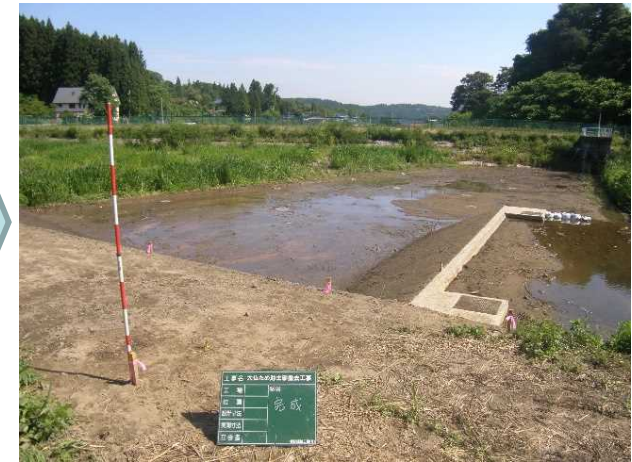
土砂浚渫により雨水貯留機能を確保
