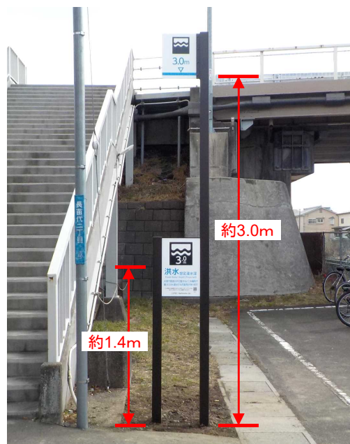
【設置状況 (JR長苗代駅)】
