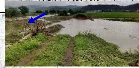
石沢川左岸【県区間】 応急復旧完了(8/3)
