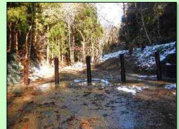
独立基礎型立木捕捉工
