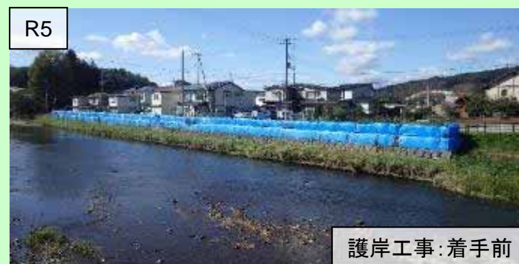
馬淵川 熊原工区 護岸工事状況について
