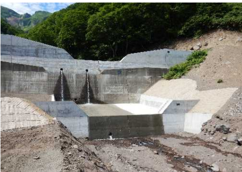
【治山: 溪間工(治山ダム)】
