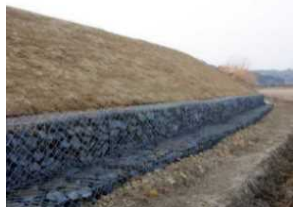
浸透対策の施工事例
