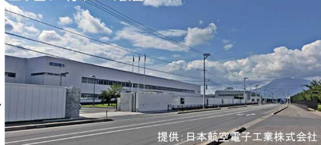
止水壁(L=約1,200m)設置
