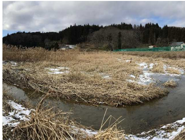
大仏ため池における土砂堆積(平均1.2m)
