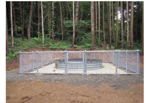
【地すべり防止工】
