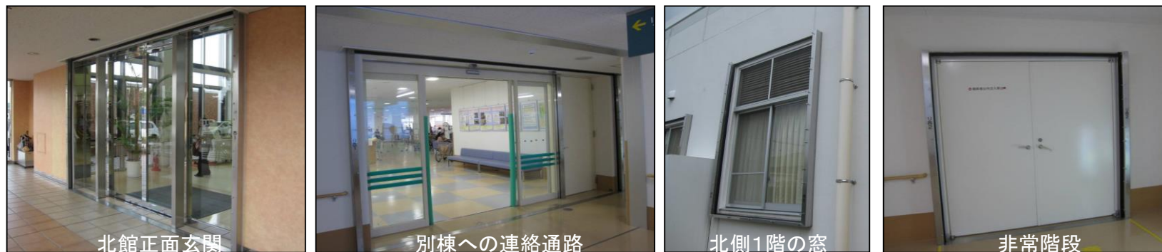
止水板のための角落としての設置
