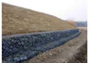
浸透対策の施工事例
