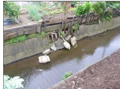
【護岸補修の実施】
