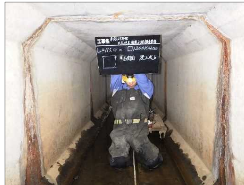
【暗渠の内部点検・補修の実施】
