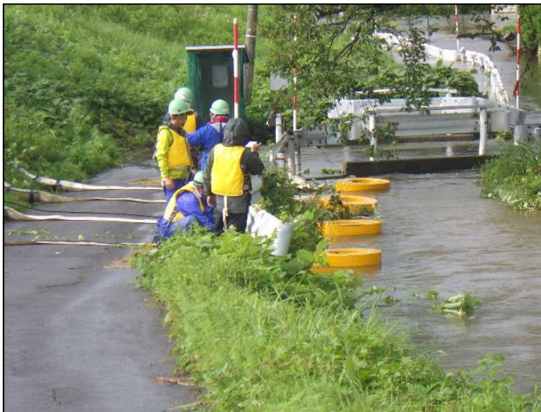
【写真1】弘前市小友地区(令和4年8月10日～11日) 国土交通省災害対策用機械派遣による排水作業
