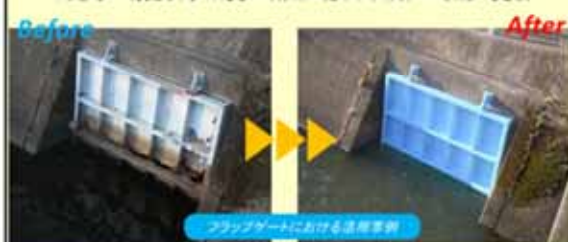
フラップゲートにおける浚渫事例
