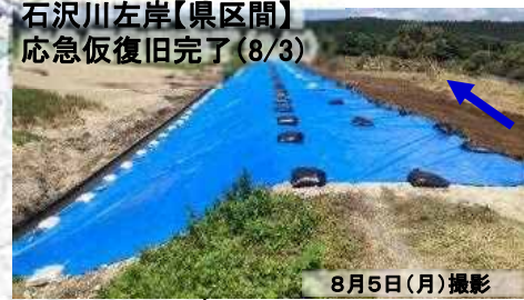
石沢川左岸1.0k付近 決壊状況(7/26) 石沢川左岸1.0k付近 復旧状況(8/2)
