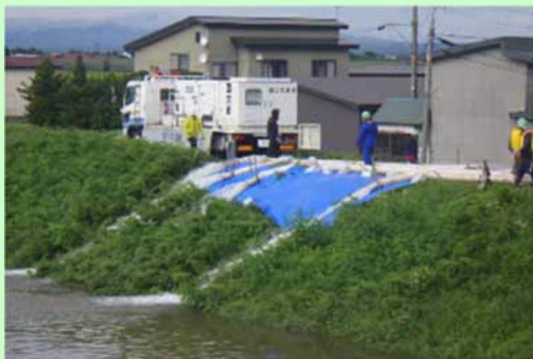
国土交通省河川国道事務所による排水作業の状況
