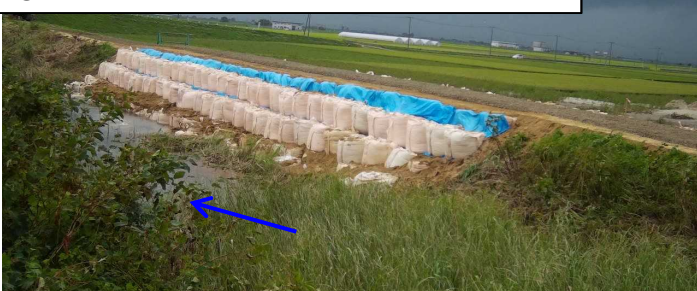
③ 応急仮締切 完了 8月23日
