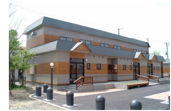
県営住宅等 新宮団地(3戸提供)
