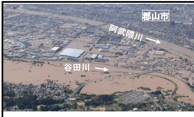
R1.10東日本台風 阿武隈川 (福島県・宮城県)
