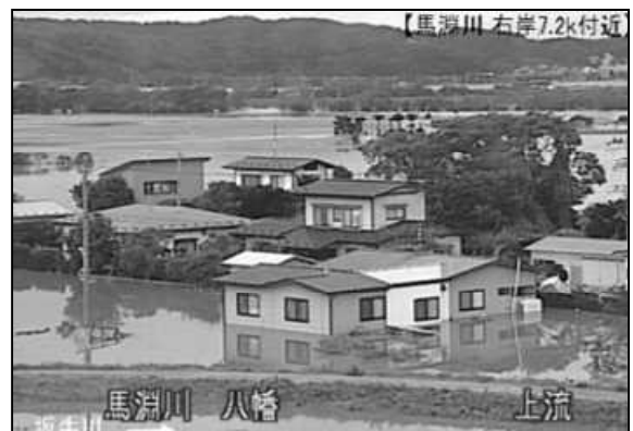
平成23年9月豪雨で浸水した八幡地区
