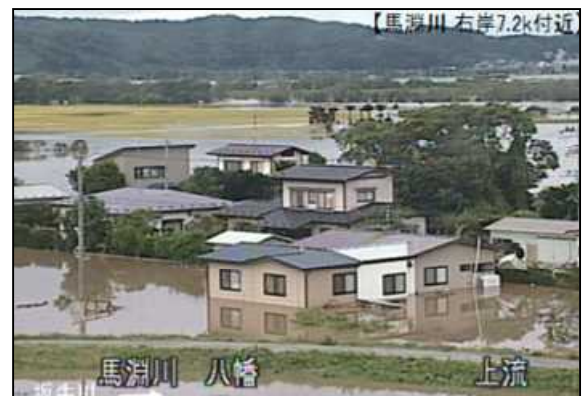
平成23年9月豪雨で浸水した八幡地区
