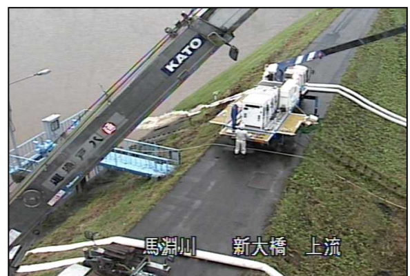
馬淵川の新大橋付近における内水排除作業状況
