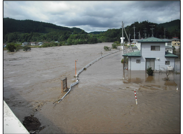
H25馬淵川洪水 （南部町門前地区の浸水状況）
