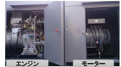
浸水への対策例: 屋上に 非常用電源 を設置
