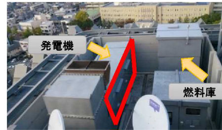
浸水への対策例: 屋上に 非常用電源 を設置
