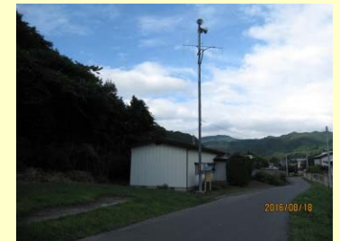
既存子局設備
