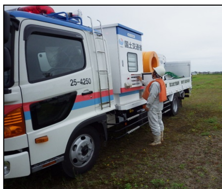
排水ポンプ車 設置訓練状況
