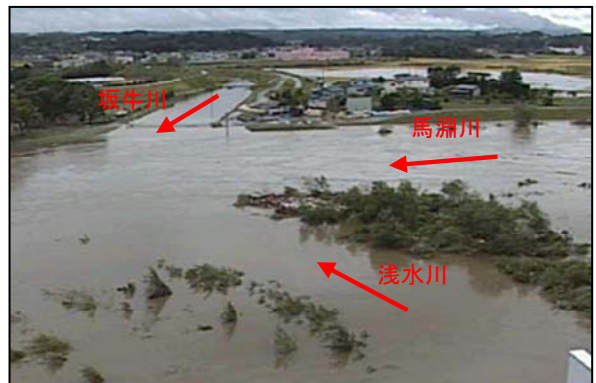
平成23年9月洪水 馬淵川・浅水川・坂牛川合流地点の状況
