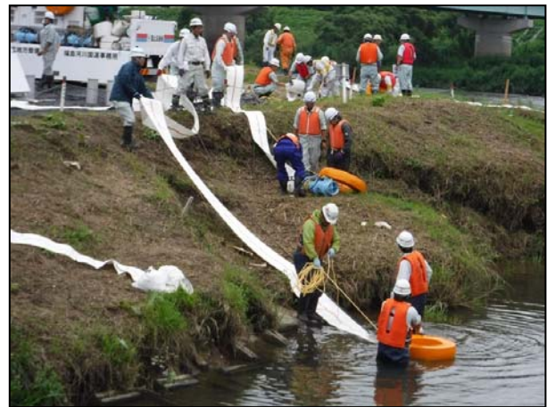
排水ポンプ始動訓練
