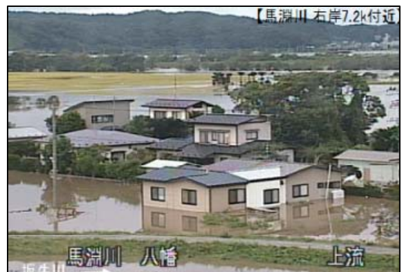
平成23年9月豪雨で浸水した八幡地区
