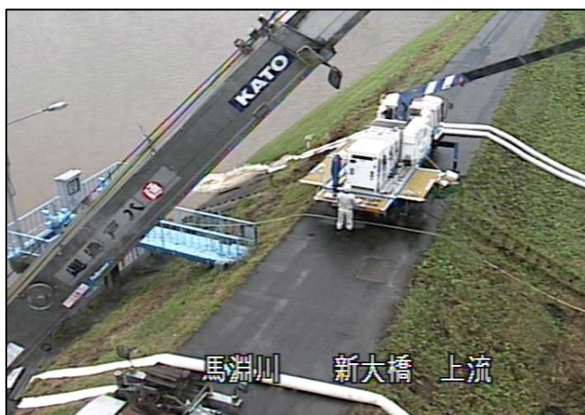
洪水時内水排除作業
