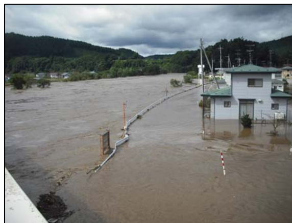
H25馬淵川洪水 (南部町門前地区の浸水状況)
