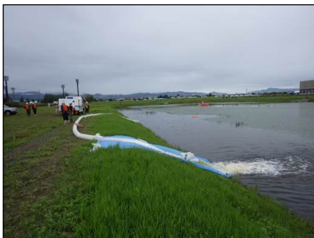
排水ポンプ車を使った訓練状況
