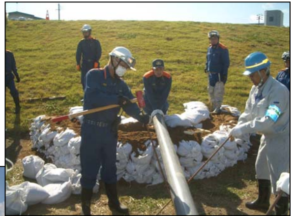
水防工法訓練実施状況
