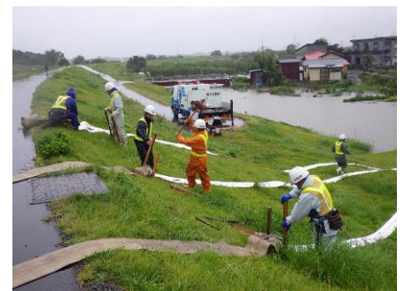
平成25年9月洪水 排水ポンプ車による排水作業 (鳴瀬排水樋管)
