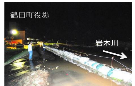
平成25年9月洪水 越水の恐れがある 箇所の水防活動 (鶴田町鶴田地先)
