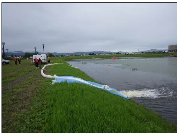
排水ポンプ車を使った訓練状況
