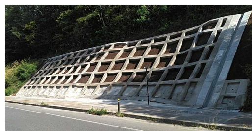
法面对策状況
