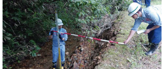
被災状況調査
