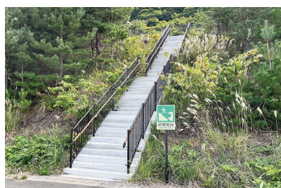
避難階段設置状況
