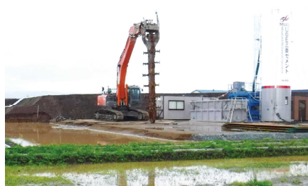
軟弱地盤改良施工状況(中層混合処理)
