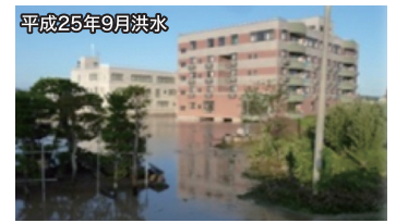
岩木川本川無堤部からの浸水状況
