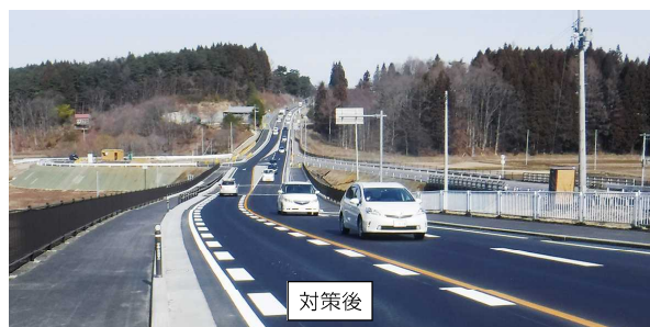
国道4号 洞内付加車線(十和田市)の事例
