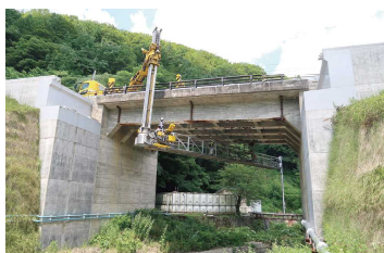
橋梁の点検状況
