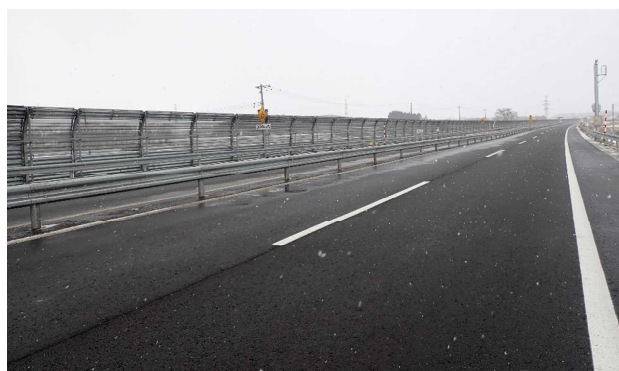
地吹雪対策として防雪柵の設置
