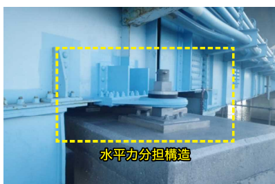
橋梁耐震補強状況
