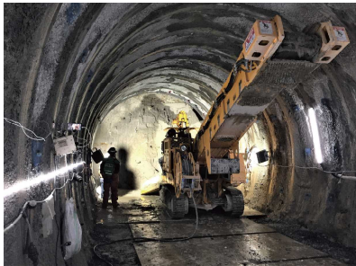
トンネル内掘削状況
