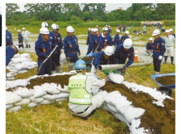
水防工法 ▶ 月の輪工を指導
