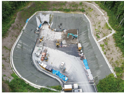
トンネル坑口部起点側
