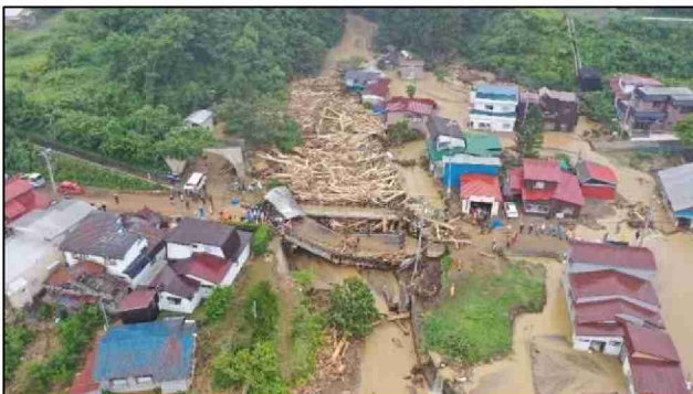
▲被災直後の小赤川橋
