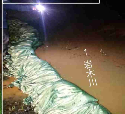
水防団による積み土のう工
