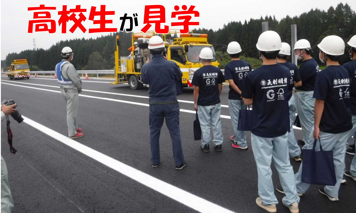
ラインマーカー車によるライン引き状況（運転席が左右2つあるのにびっくり）
