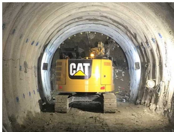
▲ツインヘッダによるトンネル掘削状況
