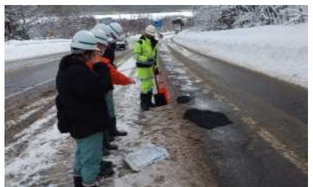
【国道7号環状道路の穴ボコ補修】
