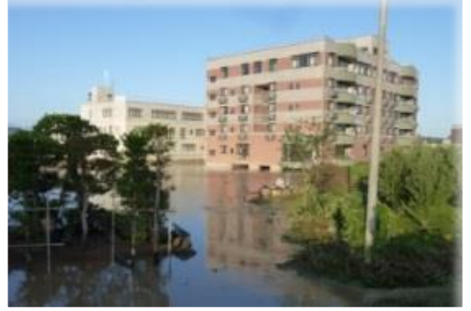
介護老人保健施設の浸水状況（弘前市大川地先）
