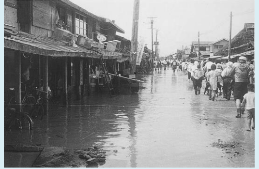
洪水氾濫により冠水した弘前市浜の町の状況
