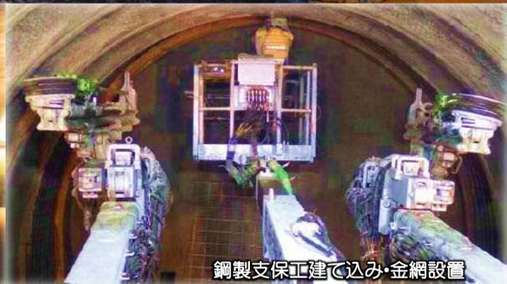
鋼製支保工建て込み・金網設置
