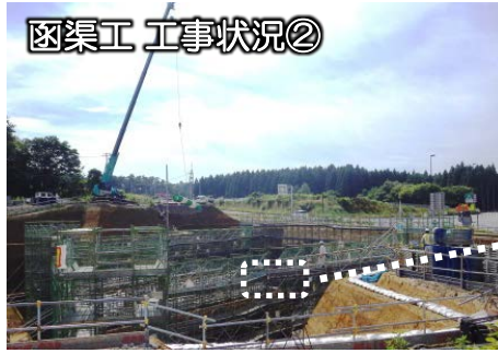
足場を使って工事状況を確認
