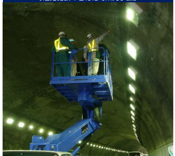
鶴ヶ花トンネルの点検の様子（国道7号 大鰐町）
